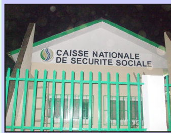
Vue de la nouvelle enseigne lumineuse de la DENNY
